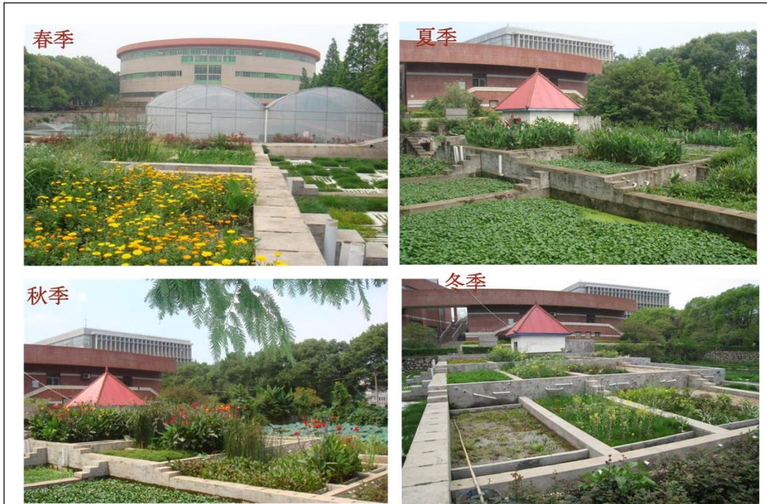
图 4 处理校园生活污水与试验废水的人工湿地处理系统
